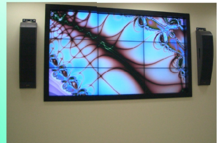
映像音響設備
